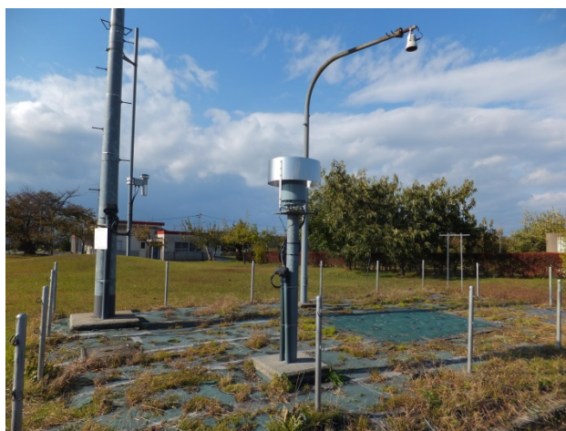
(4) 転倒ます型雨量計
